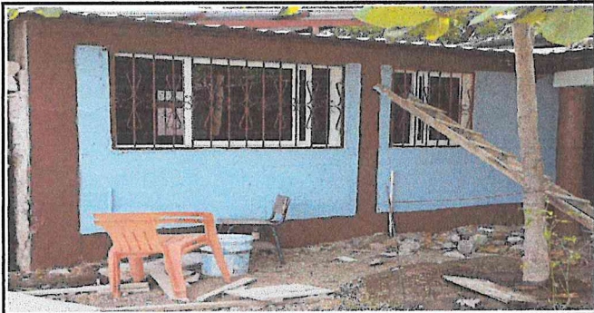
SUSTITUCION DE 5 BALCONES DE METAL POR BALCONES DE METAL DE DIFERENTES MEDIDAS AREA COCINA
