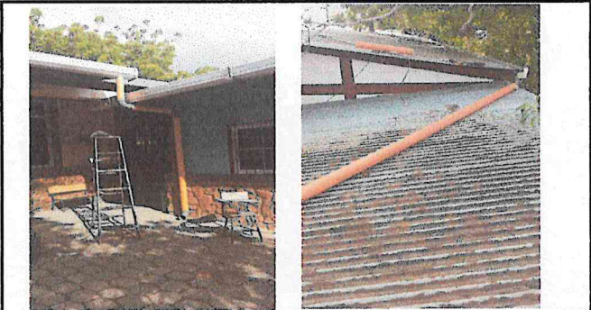
SUMINISTRO E INSTALACION DE BAJADAS DE AGUA PLUVIAL DE PVC EN CANAL DE METAL PARTE FRONTAL DE AULAS
