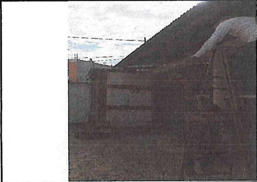
SUMINISTRO E INSTALACION DE CANAL DE METAL LADO FRONTAL Y TRASERO DE AULAS
