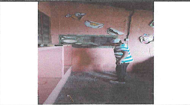
SUMINISTRO E INSTALACION DE VENTANAS DE PVC COLOR BLANCO DE DIFERENTES MEDIDAS AREA COCINA
