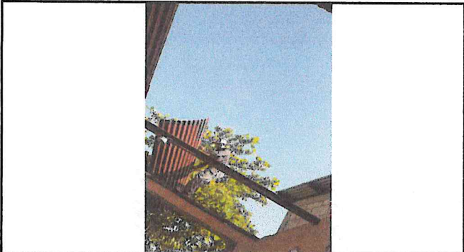
SUSTITUCION DE LAMINA POR SUMINISTRO E INSTALACION DE LAMINA TROQUELADA DE ALUZINC CALIBRE 26
