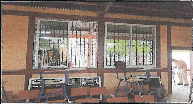
SUMINISTRO E INSTALACION DE VENTANAS DE PVC COLOR BLANCO DE DIFERENTES MEDIDAS AREA DE AULAS
