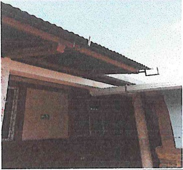
SUMINISTRO E INSTALACION DE BAJADAS DE AGUA PLUVIAL DE PVC EN CANAL DE METAL PARTE FRONTAL DE AULAS
