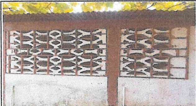
SUMINISTRO E INSTALACION DE VENTANAS DE PVC COLOR BLANCO DE DIFERENTES MEDIDAS Y SUSTITUCION DE BALCONES DE METAL, EN AREA DE COCINA
