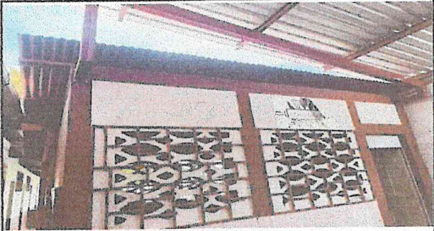
SUMINISTRO E INSTALACION DE VENTANAS DE PVC COLOR BLANCO DE DIFERENTES MEDIDAS Y SUSTITUCION DE BALCONES DE METAL, EN AREA DE COCINA
