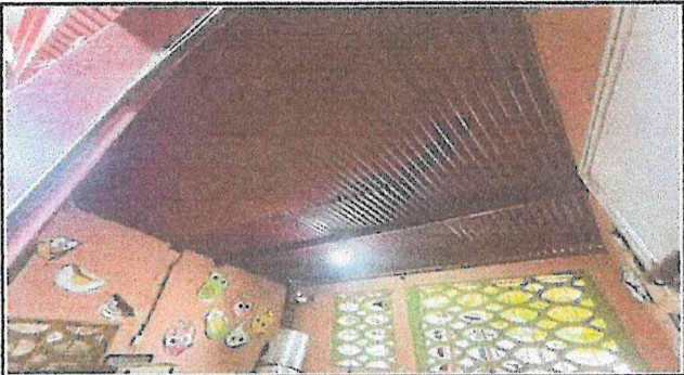
SUSTITUCION DE LAMINA E INSTALACION DE LAMINA TROQUELADA CALIBRE 26
