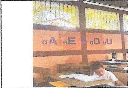
SUMINISTRO E INSTALACION DE VENTANAS DE PVC COLOR BLANCO, EN AREA DE AULAS. SE DECIDIO PRIORIZAR ESTOS TRABAJOS PORQUE EN LOS ULTIMOS DIAS DE LLUVIA TANTO POR LA PARTE TRASERA COMO FRONTAL EL AGUA SE METERA A LAS AULAS MOJANDO A LOS ALUMNOS Y QUE EN LA PARTE DE ATRAS DE LAS AULAS HACEN TORTILLAS LO CUAL EL HUMO INGRESA A LAS AULAS CAUSANDO MOLESTIA EN LOS ALUMNOS, LO CUAL CON LAS VENTANAS ESTE PROBLEMA SE MINIMIZARA
