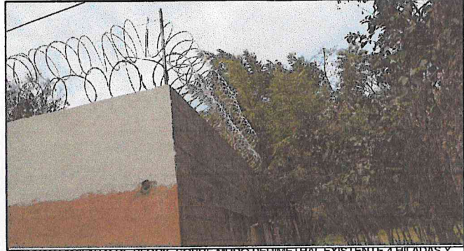
LEVANTAMIENTO DE BLOCK SOBRE MURO PERIMETRAL EXISTENTE 4 HILADAS Y SUMINISTRO E INSTALACION DE RAZOR GALVANIZADO, ESTO MITIGARA QUE LADRONES ENTREN AL ESTABLECIMIENTO A ROBAR, LA EDIFICACION SI PERMITE LEVANTAR LAS 4 HILADAS DE BLOCK
