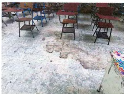
Foto 3: SUSTITUCIÓN DE PISO CERÁMICO MODULO #1
