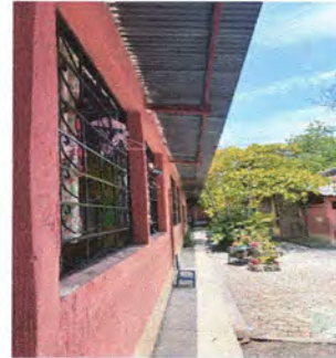
Foto 2: SUSTITUCIÓN DE LÁMINA MODULO #2
