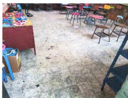
Foto 4: SUSTITUCIÓN DE PISO CERÁMICO MODULO #1
