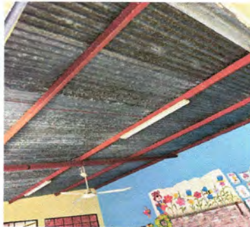
Foto 3: SUSTITUCIÓN DE LÁMINA MODULO #2
