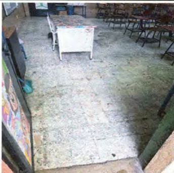
Foto1: SUSTITUCIÓN DE PISO CERÁMICO MODULO #1
