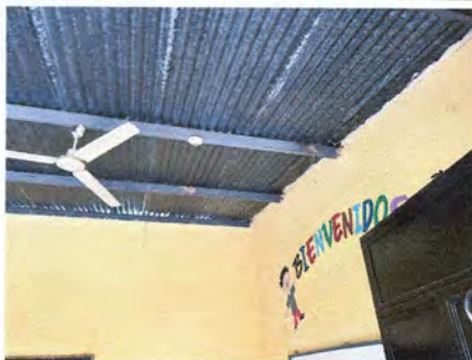
Foto 5: SUSTITUCIÓN DE LÁMINA MODULO #2
