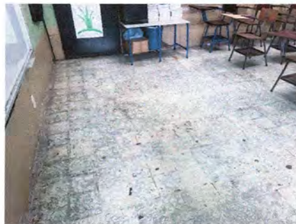
Foto 2: SUSTITUCIÓN DE PISO CERÁMICO MODULO #1
