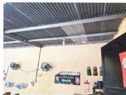
Foto 6: SUSTITUCIÓN DE LÁMINA MODULO #2
