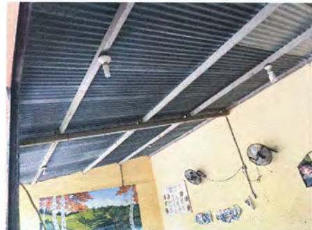
Foto 4: SUSTITUCIÓN DE LÁMINA MODULO #2
