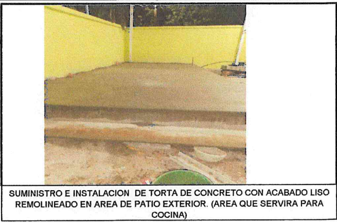
SUMINISTRO E INSTALACION DE TORTA DE CONCRETO CON ACABADO LISO REMOLINEADO EN AREA DE PATIO EXTERIOR. (AREA QUE SERVIRA PARA COCINA)
