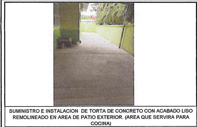
SUMINISTRO E INSTALACION DE TORTA DE CONCRETO CON ACABADO LISO REMOLINEADO EN AREA DE PATIO EXTERIOR. (AREA QUE SERVIRA PARA COCINA)
