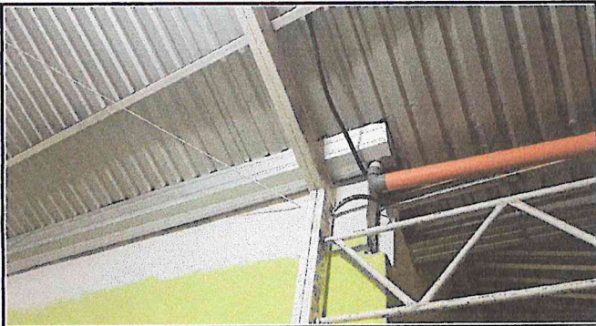
REPARACION DE DE CANAL DE METAL DE 2 AGUAS PARTE CORREDOR AFUERA DE AULAS
