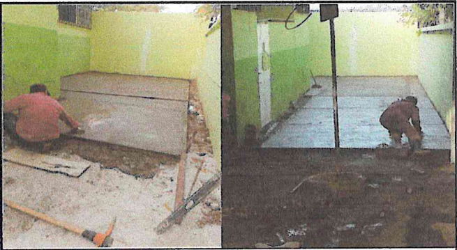
SUMINISTRO E INSTALACION DE TORTA DE CONCRETO CON ACABADO LISO REMOLINEADO EN AREA DE PATIO EXTERIOR. (AREA QUE SERVIRA PARA COCINA)
