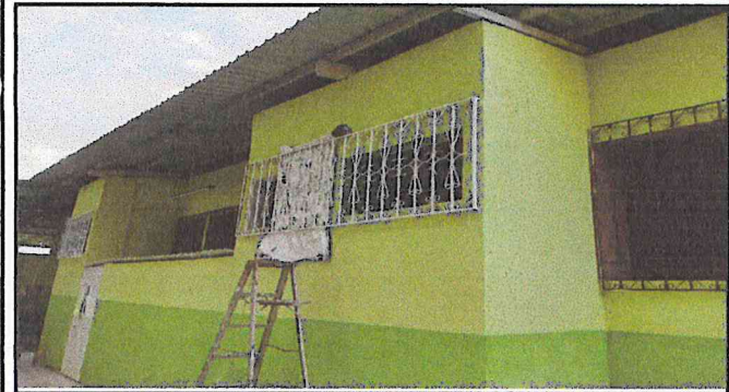
MANTENIMIENTO A BALCONES DE METAL DE 1.65X1.45 (LIJADO Y PINTADO)
