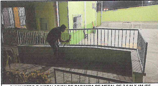
SUMINISTRO E INSTALACION DE BARANDA DE METAL DE 7.5 M X 1M (SE COLOCARA BARANDA PORQUE LOS NIÑOS SE TIRAN DE LA RAMPA A LA CANCHA Y YA SE HAN PRESENTADO ALGUNOS ACCIDENTES)
