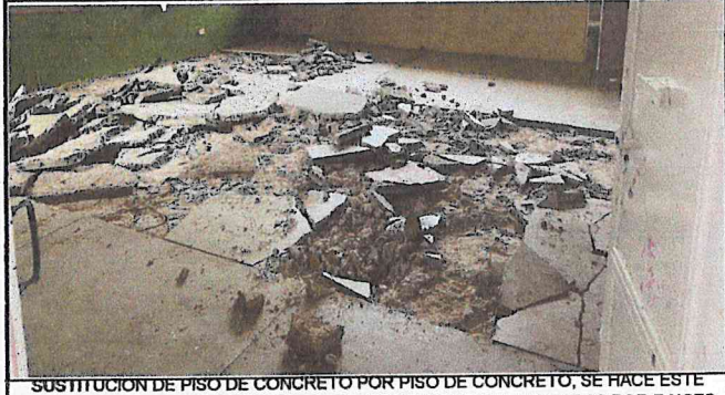
SUSTITUCION DE PISO DE CONCRETO POR PISO DE CONCRETO, SE HACE ESTE CAMBIO PORQUE LAS PLANCHAS ESTAN AGRIETADAS Y LEVANTADAS POR RAICES DE ARBOLES QUE SE UBICAN EN LA PARTE TRASERA DE LAS AULAS LO CUAL CAUSA QUE LOS NIÑOS SE TROPIEZEN
