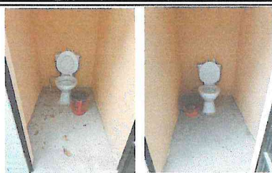
SUMINISTRO E INSTALACION DE SANITARIOS EN AREA EXTERIOR DEL ESTABLECIMIENTO DE BUEN ACALIDAD DE UNA SOLA PIEZA TIPO PUSH.
