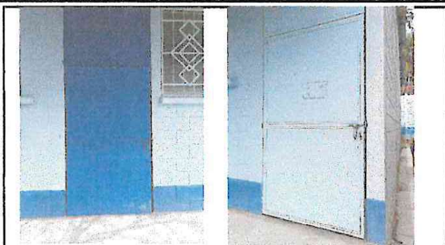
MANTENIMIENTO A PUERTAS DE METAL EN AULAS (LIJADO Y PINTADO) 1.20 X 3.10 M2, INSTALACION DE CHAPA YALE A CADA UNA
