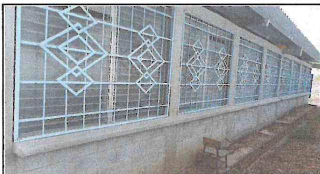
SUMINISTRO E INSTALACION DE PINTURA DE LATEX ACRILICA DE BUENA CALIDAD EN MUROS INTERIORES Y EXTERIORES DE AULAS
