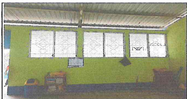
SUMINISTRO E INSTALACION DE VENTANAS DE PVC COLOR BLANCO CON REJILLA Y MOSQUITERO (INCLUYE DESMONTAJE DE VENTANAS EXISTENTES) EN AREA DE AULAS
