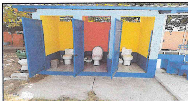
SUMINISTRO E INSTALACION DE SANITARIOS DE BUENA CALIDAD DE UNA SOLA PIEZA TIPO PUSH. Y INSTALACION DE PISO AZULEJO EN EL SUELO
