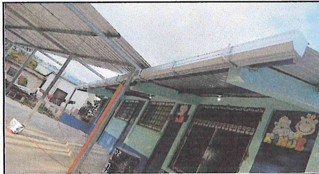
SUMINISTRO E INSTALACION DE CANAL DE METAL AREA FRONTAL DE AULAS CON SUS BAJADAS DE AGUA PLUVIAL
