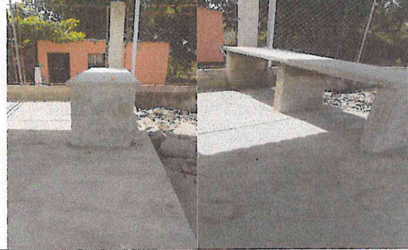
FABRICACION DE MESA DE COCINA DE CONCRETO CON ACABADO DE CERNIDO FINO DE CEMENTO DE 0.60 ANCHO, 0.85 ALTO Y 2.50 LARGO
