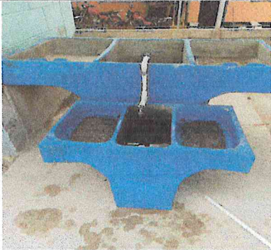
SUSTITUCION DE PILA PREFABRICADA POR PILAS PREFABRICADA DE CEMENTO. DE 0.65 ANCHO, 1.10 LARGO Y 0.65 ALTO ( ESPECIAL PARA NIÑOS)
