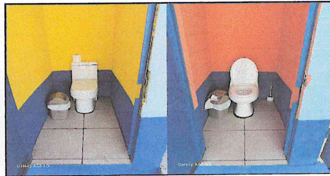
SUMINISTRO E INSTALACION DE SANITARIO DE BUENA CALIDAD PEQUEÑO PARA NIÑOS Y INSTALACION DE PISO AZULEJO EN EL SUELO
