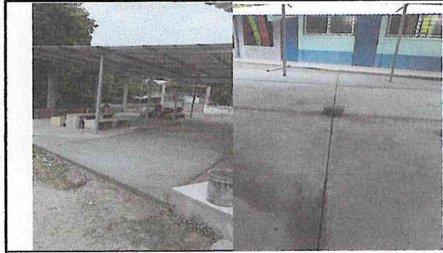
SUMINISTRO E INSTALACION DE TORTA DE CONCRETO CON ACABADO FINO REMOLINEADO, EN AREA DE PATIO EXTERIOR.
