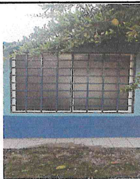
SUMINISTRO E INSTALACION DE PINTURA DE BUENA CALIDAD EN INTERIOR Y EXTERIOR DE AULA
