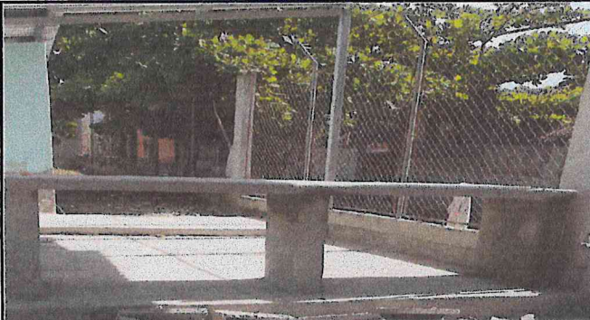
FABRICACION DE MESA DE COCINA DE CONCRETO CON ACABADO DE CERNIDO FINO DE CEMENTO DE 0.60 ANCHO, 0.85 ALTO Y 2.50 LARGO
