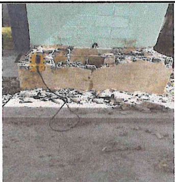
SUSTITUCION DE PILA PREFABRICADA POR PILAS PREFABRICADA DE CEMENTO. DE 0.65 ANCHO, 1.10 LARGO Y 0.65 ALTO ( ESPECIAL PARA NIÑOS)
