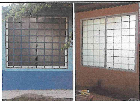
SUMINISTRO E INSTALACION DE VENTANAS DE PVC COLOR BLANCO DE DIFERENTES MEDIDAS
