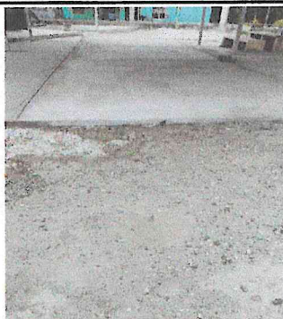
SUMINISTRO E INSTALACION DE TORTA DE CONCRETO CON ACABADO FINO REMOLINEADO, EN AREA DE PATIO EXTERIOR.
