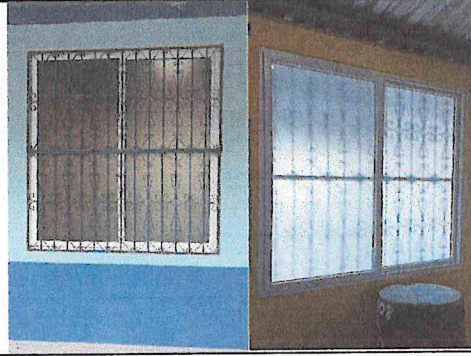
SUMINISTRO E INSTALACION DE VENTANAS DE PVC COLOR BLANCO DE DIFERENTES MEDIDAS
