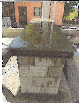
FABRICACION DE MESA DE COCINA DE CONCRETO CON ACABADO DE CERNIDO FINO DE CEMENTO DE 0.60 ANCHO, 0.85 ALTO Y 2.50 LARGO
