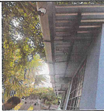
SUMINISTRO E INSTALACION DE CANAL DE METAL AREA TRASERA DE AULAS CON SUS BAJADAS DE AGUA PLUVIAL
