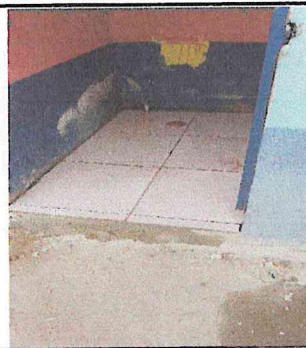
SUMINISTRO E INSTALACION DE SANITARIO DE BUENA CALIDAD PEQUEÑO PARA NIÑOS Y INSTALACION DE PISO AZULEJO EN EL SUELO
