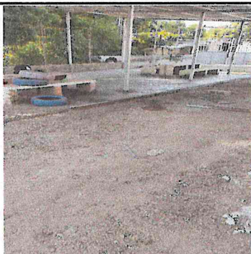
SUMINISTRO E INSTALACION DE TORTA DE CONCRETO CON ACABADO FINO REMOLINEADO, EN AREA DE PATIO EXTERIOR.
