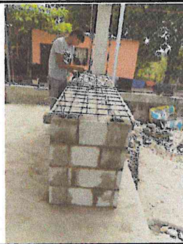
FABRICACION DE MESA DE COCINA DE CONCRETO CON ACABADO DE CERNIDO FINO DE CEMENTO DE 0.60 ANCHO, 0.85 ALTO Y 2.50 LARGO
