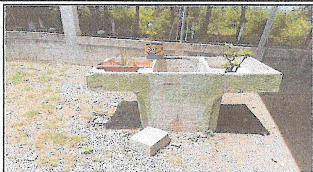
SUSTITUCION DE PILA PREFABRICADA POR PILAS PREFABRICADA DE CEMENTO. DE 0.65 ANCHO, 1.10 LARGO Y 0.65 ALTO ( ESPECIAL PARA NIÑOS)
