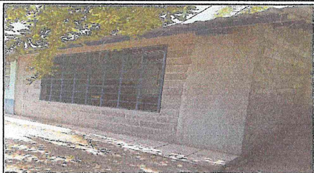
SUMINISTRO E INSTALACION DE PINTURA DE BUENA CALIDAD EN INTERIOR Y EXTERIOR DE AULA
