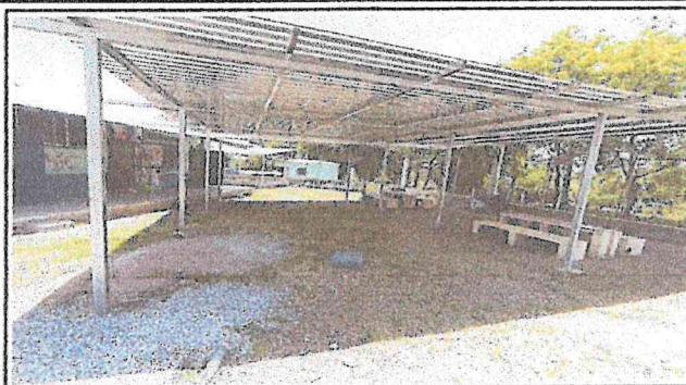
SUMINISTRO E INSTALACION DE TORTA DE CONCRETO CON ACABADO FINO REMOLINEADO, EN AREA DE PATIO EXTERIOR.
