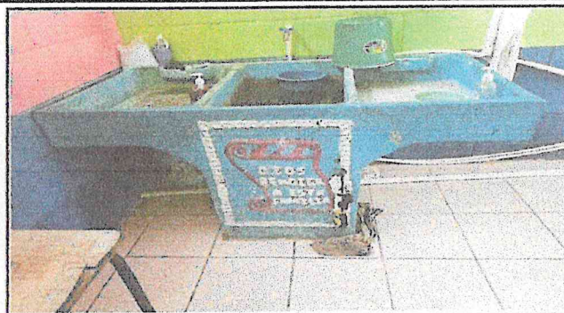
SUSTITUCION DE PILA PREFABRICADA POR PILA PREFABRICADA DE CEMENTO. DE 0.75 ANCHO, 1.45 LARGO Y 0.85 ALTO
