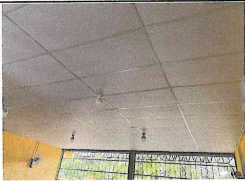
Foto1: Instalación de Cielo Falso vinyl G239-1 sistegua 2x4 (nucleo yeso)
