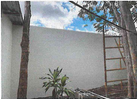
Foto 6: Repello en muro
