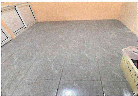
Foto 5: Sustitución de piso de cemento a piso ceramico
