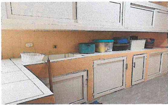
Foto 4: Instalación de azulejos en gabinete
