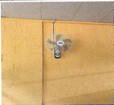
Foto7: Sustitución de ventiladores
