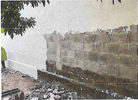
Foto 2: Levantamiento de 80 centímetros de block x70 de largo
