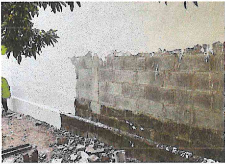
Foto 6: Repello en muro
