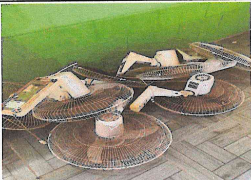
Foto7: Sustitución de ventiladores
