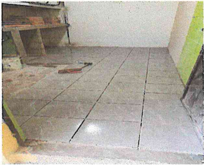
Foto 5: Sustitución de piso de cemento a piso ceramico
