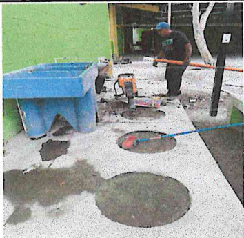
Foto 8: Instalación de Tubería PVC línea principal aguas pluviales
