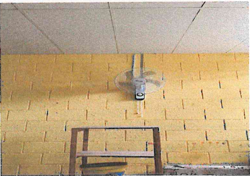
Foto1: Instalación de Cielo Falso vinyl G239-1 sistegua 2x4 (nucleo yeso)
