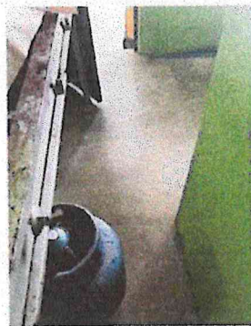
Foto 16: Sustitución de Piso de Cemento a Cerámico en Cocina.
