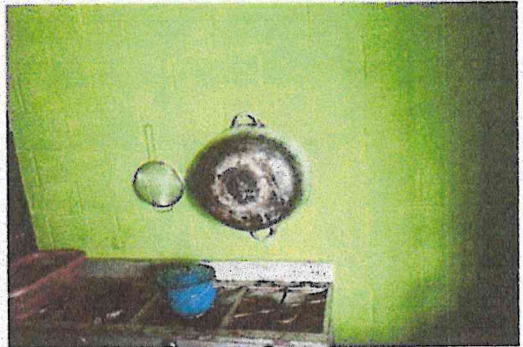
Foto 8: Elaboración de 12 metros de Gabinete en cocina (incluye puertas y forrado de azulejo. Pared 2)
