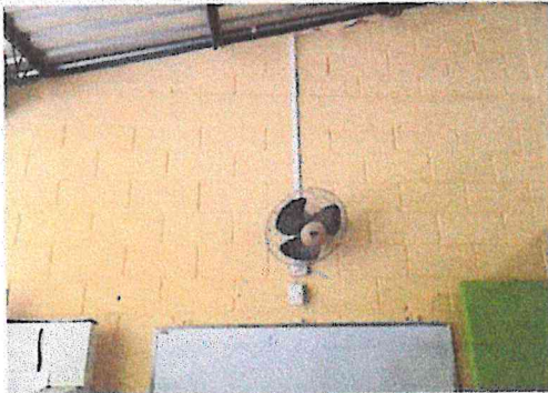
Foto13: Instalacion de ventiladores de pared con circuito propio
