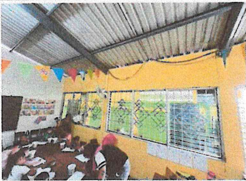
Foto 3: Instalación de Cielo Falso Vinyl G239-1 Sistegua 2x4 (nucleo Yeso)
