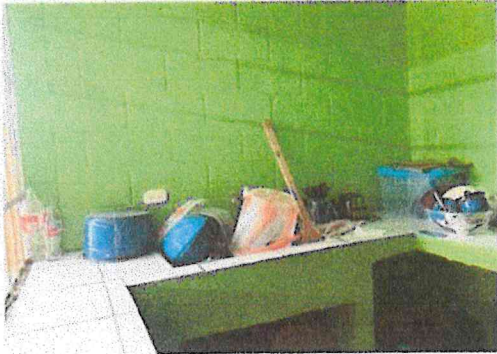
Foto7: Elaboración de 12 metros de Gabinete en cocina (incluye puertas y forrado de azulejo. Pared 1)
