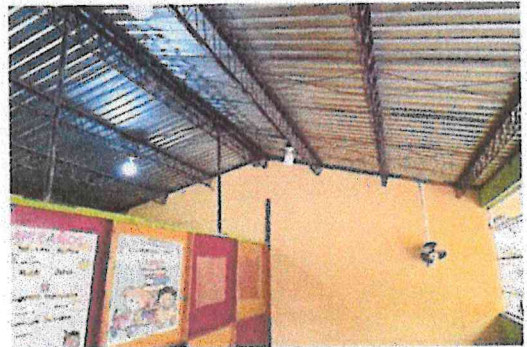
Foto 14: Instalacion de ventiladores de pared con circuito propio
