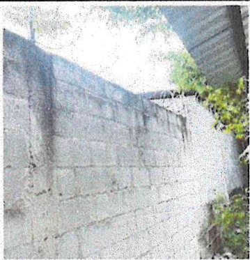
Foto 5: Levantamiento de 80 centímetros de Block x50 de largo
