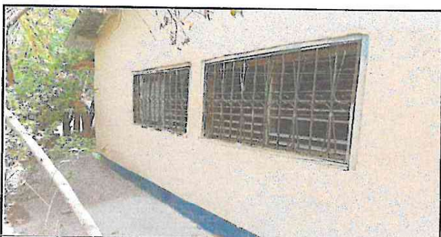
SUMINISTRO E INSTALACION DE VENTANAS DE PVC DE COLOR BLANCO CON REJILLA Y MOSQUITERO
