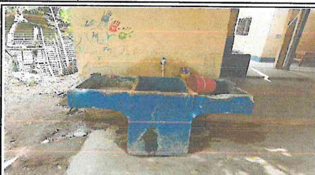
SUSTITUCION DE PILA PREFABRICADA POR PILA FUNDIDA DE 2 LAVADEROS DE 1X1.60X 0.80 Y INSTALACION DE AZUELJO EN INTERIOR Y EXTERIOR DE PILA
