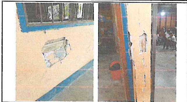
SELLADO DE GRIETAS EN PAREDES
