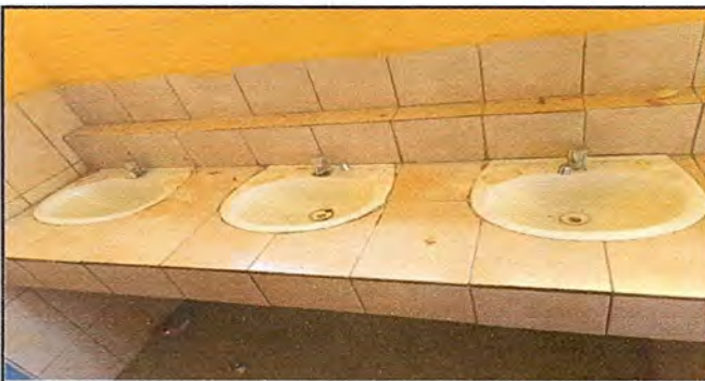
SUMINISTRO E INSTALACION DE ACCESORIOS PARA LAVAMANOS (LLAVE, CONTRALLAVE, TUBO DE ABASTO Y SIFON)
