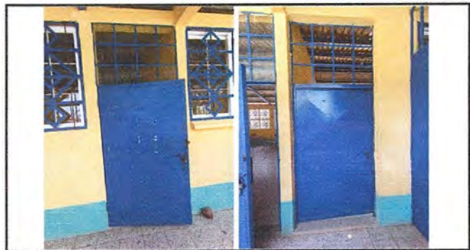
MANTENIMIENTO A 6 PUERTAS DE METAL EN AREA DE AULAS (LIJADO Y PINTADO) 1.20X3 Y SUMINISTRO E INSTALACION DE CHAPA YALE EN 7 PUERTAS
