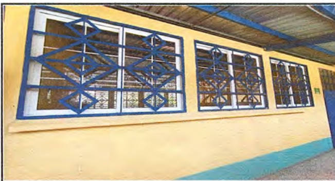
INSTALACION DE MOSQUITEROS DE METAL EN LA PARTE FRONTAL DEL ESTABLECIMIENTO MEDIDA 1.70 X 1.50 MTS.
