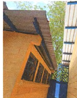
SUMINISTRO E INSTALACION DE CANAL DE METAL AREA EXTERIOR DE BAÑOS, CON SUS BAJADAS DE AGUA PLUVIAL
