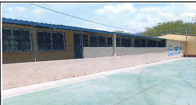
SUMINISTRO E INSTALACION DE PINTURA DE BUENA CALIDAD EN PARTE FRONTAL DE ESTABLECIMIENTO
