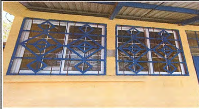
MANTENIMIENTO A BALCONES DE METAL EN AULAS (LIJADO Y PINTADO) 1.70X1.50
