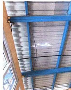
SUSTITUCION DE LAMINA TROQUELADA DE ALUZINC CALIBRE 26, EN AREA DE AULAS Y CORREDOR FRENTE A AULAS, ( MALOS VECINOS TIRAN BOMBAS AL TECHO PROVOCANDO QUE ESTAS SE AGRIETEN.
