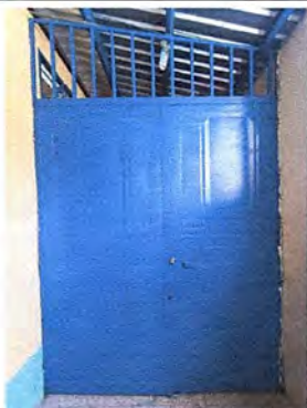
MANTENIMIENTO A PORTON EN CORREDOR AFUERA DE AULAS MEDIDA DE 2.50X3.40
