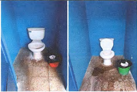
SUMINISTRO E INSTALACION DE SANITARIOS DE BUENA CALIDAD AREA DE BAÑOS
