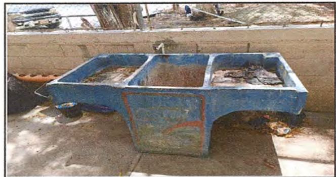
SUSTITUCION DE PILA PREFABRICADA POR PILA FUNDIDA DE 2 LAVADEROS DE 1X2X 0.80 CON ACABADO FINO EN AREA INTERIOR Y ACABADO CON AZULEJO EN AREA EXTERIOR
