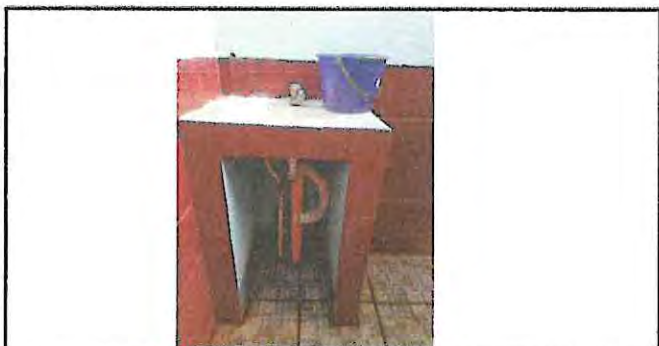
SUMINISTRO E INSTALACION DE ACCESORIOS PARA LAVAMANOS (LLAVE, CONTRALLAVE, TUBO DE ABASTO Y SIFON)
