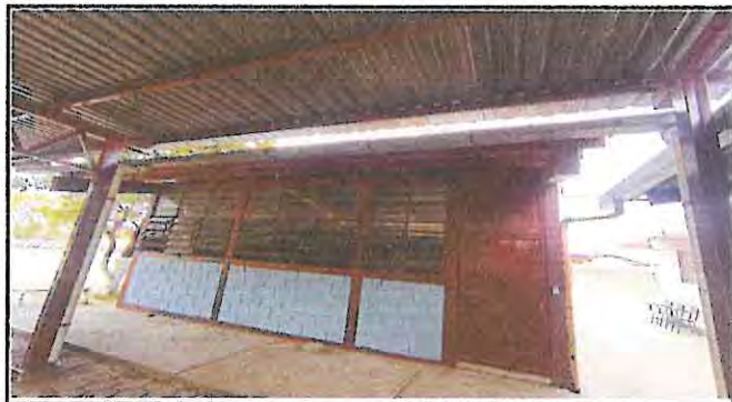
SUMINISTRO E INSTALACION DE CANAL DE METAL AREA EXTERIOR DE AULAS PARTE FRONTAL DE AULAS Y CORREDOR PRINCIPAL, CON SUS BAJADAS DE AGUA PLUVIAL.
