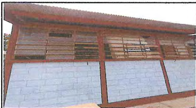
SUMINISTRO E INSTALACION DE VENTANAS DE PVC DE COLOR BLANCO CON REJILLA Y MOSQUITERO EN AREA DE AULAS Y MANTENIMIENTO A BALCONES DE METAL (LIJADO Y PINTADO, ELIMINACION DE VIDRIOS EN MAL ESTADO, SOLO SE DEJARA EL MARCO DEL BALCON) MEDIDAS DE LOS BALCONES ES DE 2.30X1.78
