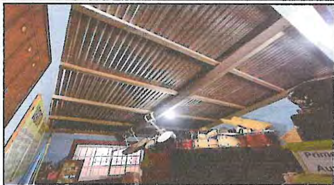
SUMINISTRO E INSTALACION DE CIELO FALSO EN DIRECCION
