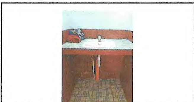
SUMINISTRO E INSTALACION DE ACCESORIOS PARA LAVAMANOS (LLAVE, CONTRALLAVE, TUBO DE ABASTO Y SIFON)
