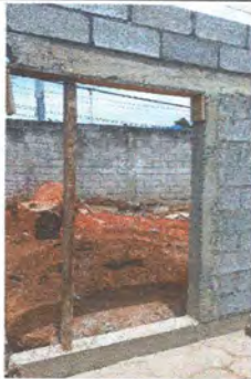
SUMINISTRO E INSTALACION DE PUERTA DE METAL EN DIRECCION MEDIDAD DE 1.20 X 2
