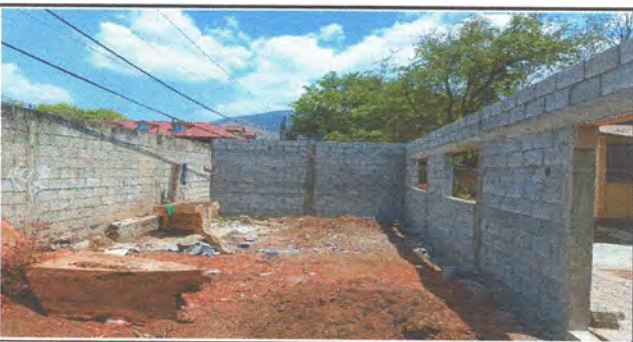
SUMINISTRO Y INSTALACION DE DUCTO ELECTRICO, CABLEADO ELECTRICO, TOMACORRIENTES, INTERRUPTORES, PLAFONERAS Y FOCOS
