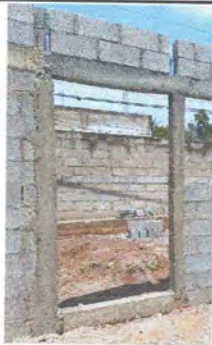
SUMINISTRO E INSTALACION DE PUERTA DE METAL EN DIRECCION MEDIDAD DE 1.20 X 2
