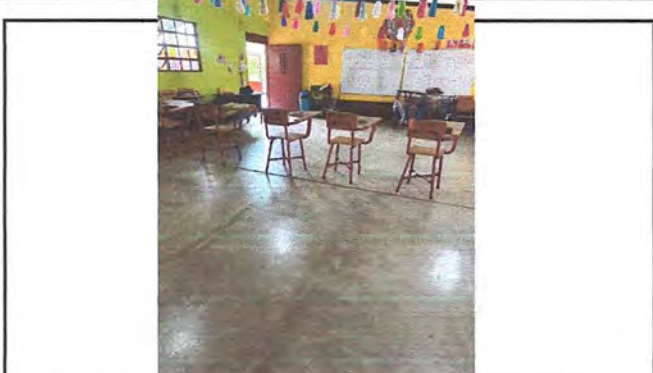
Foto 4: 2.2sustitucion de piso ceramico
