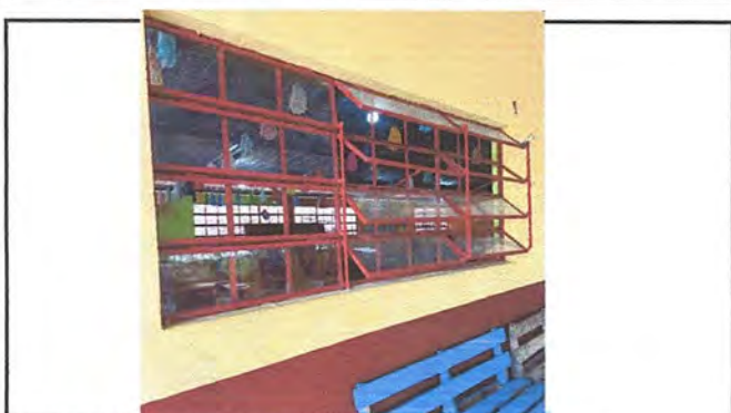
Foto 3: 2.1 instalacion de ventanas pvc
