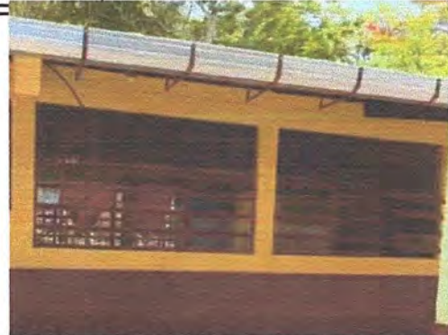
4.2 instalacion de ventanas pvc
