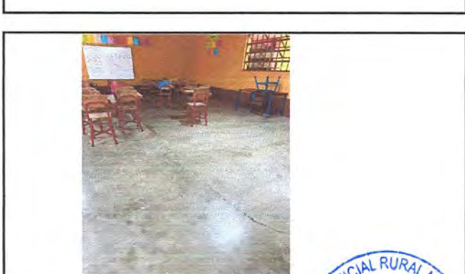
Foto 6: 3.2 sustitucion de piso ceramico
