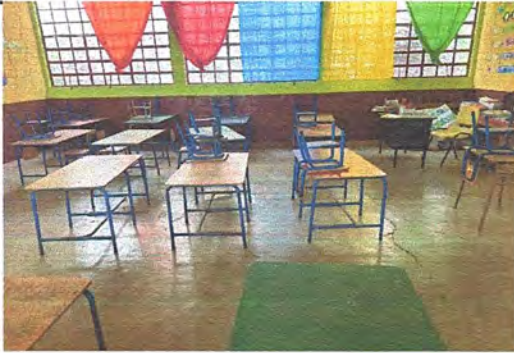
4.1 sustitucion de piso ceramico
