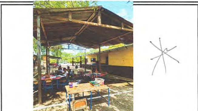
Foto 2: 1.2 sustitucion de lamina troquelada aluizinc cal 26
