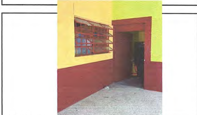
Foto 5: 3.1 instalacion de ventanas pvc
