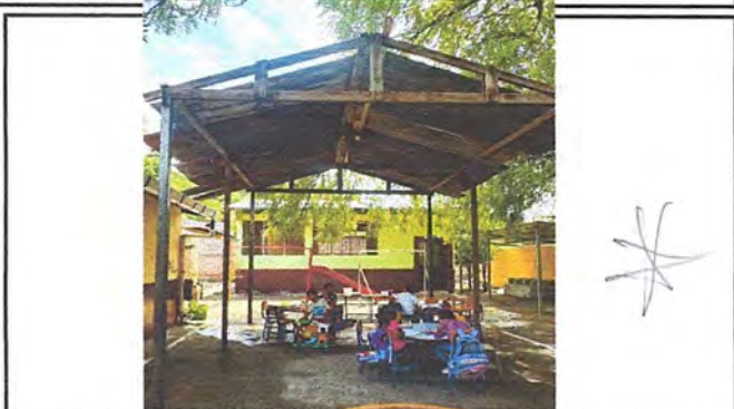
Foto1: 1.1 sustitucion de estructura de soporte de madera, por soporte de metal
