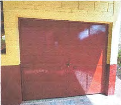
4.3 sustitucion de chapa
