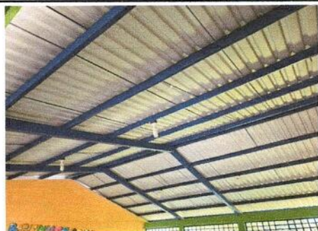
Foto 9: instalacion Cielo falso
