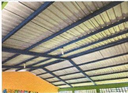
Foto 9: instalacion Cielo falso
