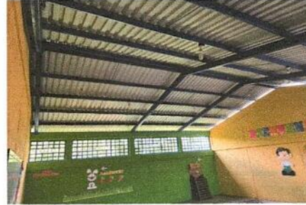
Foto 8: instalacion Cielo falso
