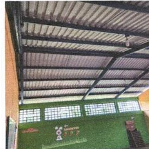
Foto 10: instalacion Cielo falso
