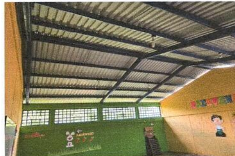
Foto 8: instalacion Cielo falso
