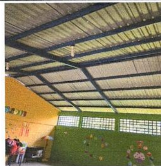
Foto 12: nstalacion de Ventana PVC.
