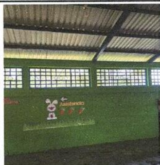
Foto 11: instalacion de Ventana PVC.
