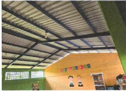
Foto7: instalacion Cielo falso
