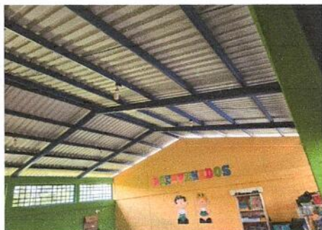
Foto7: instalacion Cielo falso
