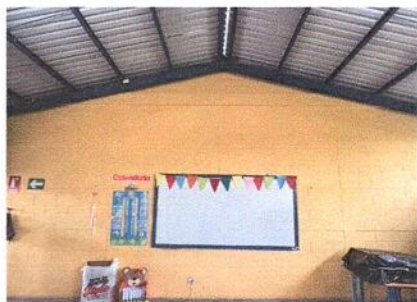
Foto 13: Instalación de ventiladores giratorios en pared
