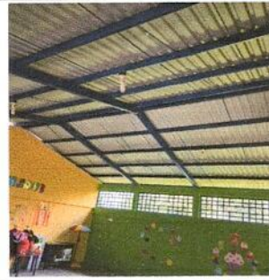
Foto 12: nstalacion de Ventana PVC.
