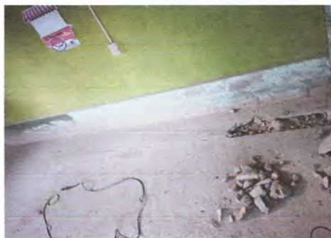
Foto 8: susutitución de concreto por piso cerámico
