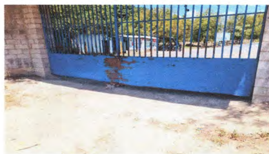
Foto 4: Mantenimiento a portones de metal (cuneta)
