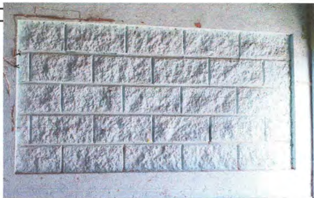
Foto 9: reparación de cernido en paredes exteriores e interiores de baño
