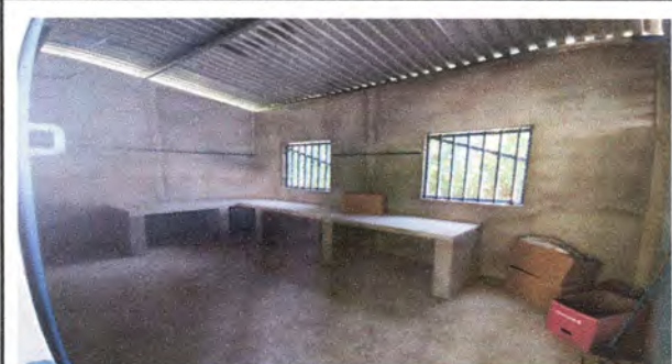
Foto 3: instalación de siete puertas, tres puertas de dos hojas y una sola puerta.
