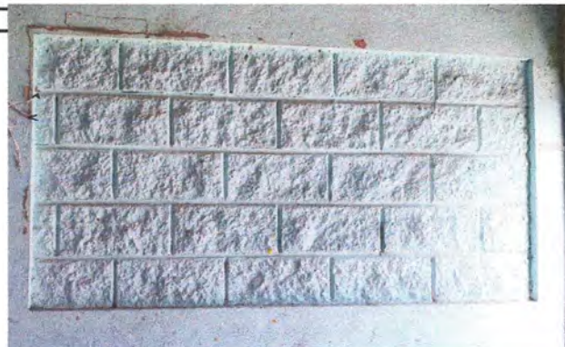
Foto 10: pintura de muros exteriores e interiores de baño
