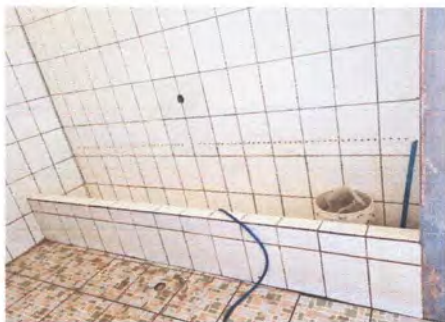
Foto 7: suministro e instalación de mingitorio con fluxómetro
