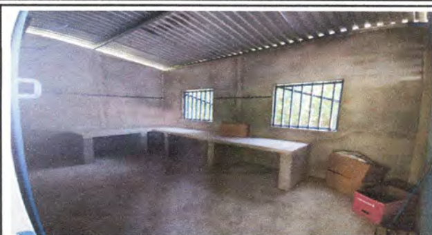
Foto1: Sustitución de piso cerámico
