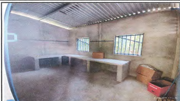
Foto 2: Pintura en muros exteriores e interiores
