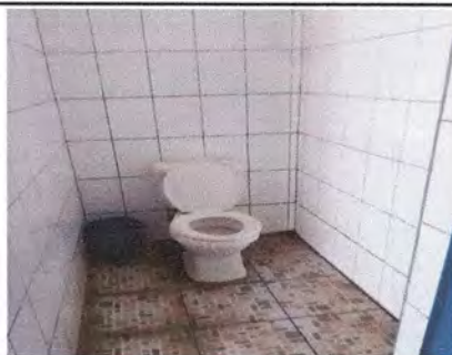
Foto 5: Sustitución de inodoros
