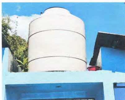
Foto 5: SUSTITUCIÓN DE DEPOSITO DE AGUA DE 1100 LT (SUSTITUCIÓN DE DEPOSITO, LLAVES DE PASO).
