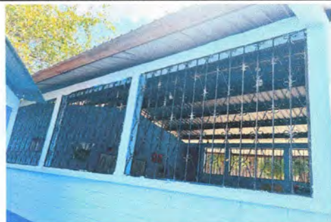
Foto 5: MANTENIMIENTO A BALCONES DE METAL (LIJADO, CEPILLADO Y APLICACIÓN DE PINTURA).
