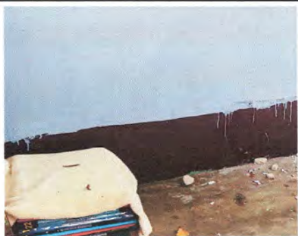
Foto1: PINTURA EN MUROS INTERIORES.
