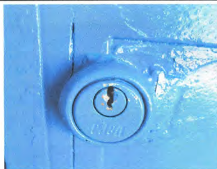
Foto 4: SUSTITUCIÓN DE CHAPAS EN PUERTAS DE METAL.
