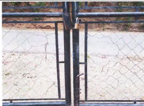
Foto 2: MANTENIMIENTO A PORTÓN DE METAL 2.0*3.0 LIJADO, SUJECCIÓN, PINTURA.
