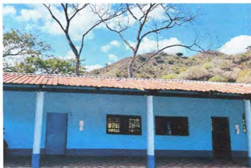
Foto 3: APLICACIÓN DE PINTURA PARA RECUBRIMIENTO DE LÁMINA.
