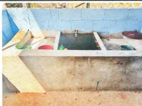
Foto 2: INSTALACIÓN DE AZULEJO EN PILA DE CONCRETO.
