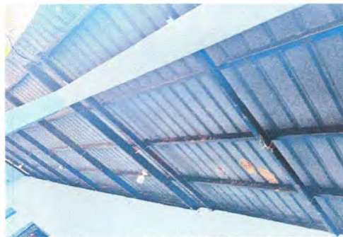
Foto 4: DESMONTAJE Y SUSTITUCIÓN DE LAMINA TROQUELADA CALIBRE 26 DE 16P.
