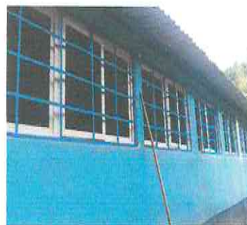
MANTENIMIENTO DE BALCONES CUADRICULA 0.25X0.50m (ENDEREZADO, LIJADO, CEPILLADO, PINTURA, INSTALACION)
