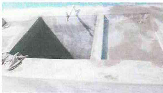
SUSTITUCION DE PILA (2.00X0.80m)
