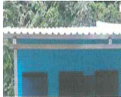
SUSTITUCIÓN DE LAMINA, POR LAMINA TROQUELADA ALUZINC CALIBRE 26(4.7X400m)
