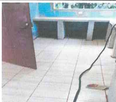
SUSTITUCION DE PISO CERAMICO
