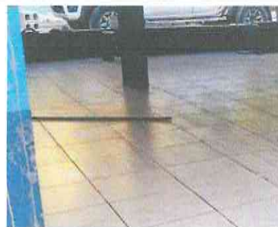
SUSTITUCION DE PISO CERAMICO SALA REUNIONES
