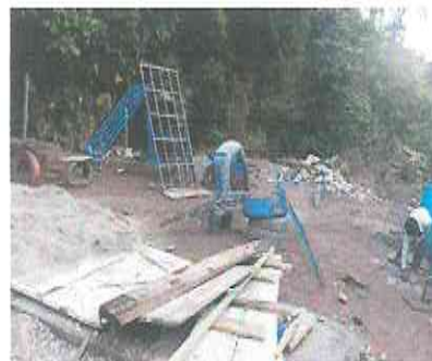
MANTENIMIENTO DE BALCONES CUADRICULA 0.25X0.50m (ENDEREZADO, LIJADO, CEPILLADO, PINTURA, INSTALACION)
