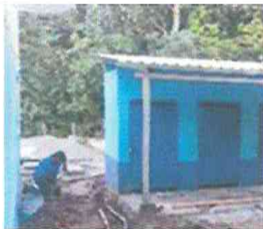
SUSTITUCION A ESTRUCTURA DE SOPORTE DE METAL(4.70X4.00m).
