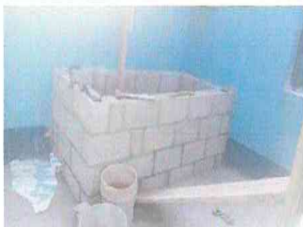
SUSTITUCION DE PILA (2.00X0.80m)
