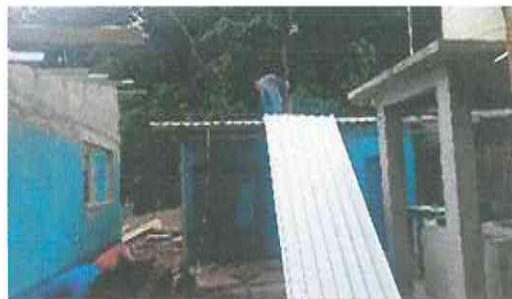
SUSTITUCIÓN DE LAMINA, POR LAMINA TROQUELADA ALUZINC CALIBRE 26(4.7X400m)
