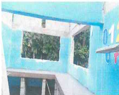
SUSTITUCIÓN DE VENTANAS POR VENTANAS DE PVC CORREDIZAS COLOR BLANCO(1.50X1.00m)
