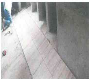
SUSTITUCION DE PISO CERAMICO
