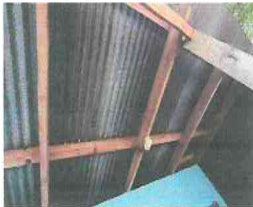
SUSTITUCION A ESTRUCTURA DE SOPORTE DE METAL(4.70X4.00m).
