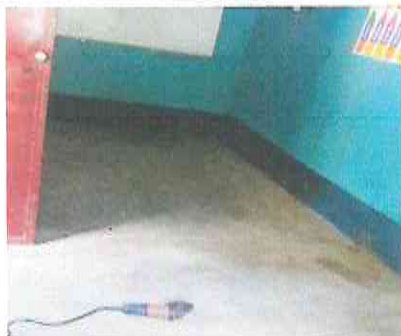
SUSTITUCION DE GABINETE L MEDIDAS (3.0 m X 2.50 X 0.80 H=0.80)
