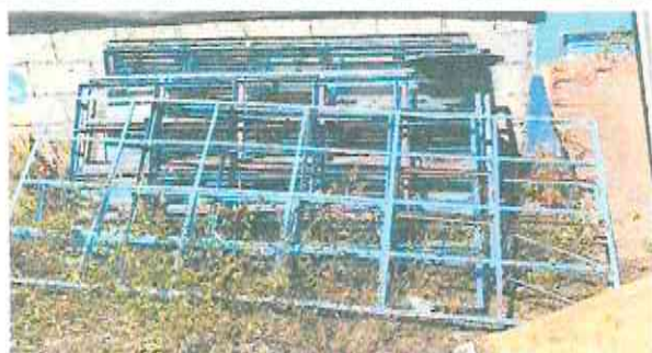
MANTENIMIENTO A BALCONES (ENDEREZADO, LIJADO, CEPILLADO, PINTURA, INSTALACIÓN)
