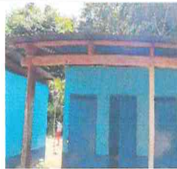
SUSTITUCIÓN DE LAMINA, POR LAMINA TROQUELADA ALUZINC CALIBRE 26(4.7X4.00m)
