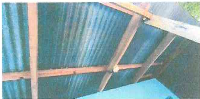
SUSTITUCIÓN DE ESTRUCTURA DE SOPORTE DE METAL
