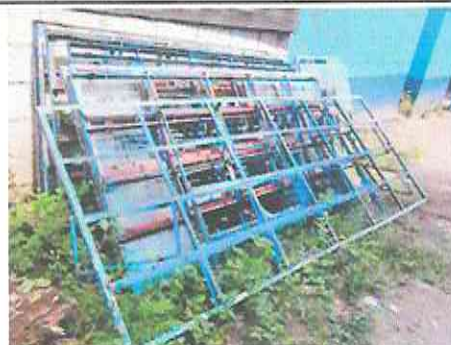
MANTENIMIENTO DE BALCONES CUADRICULA 0.25X0.50m (ENDEREZADO, LIJADO, CEPILLADO, PINTURA, INSTALACION)
