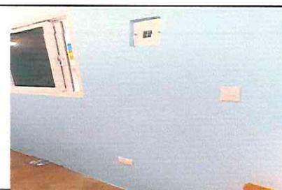
Foto 6: SUSTITUCION DE FLIPONES
