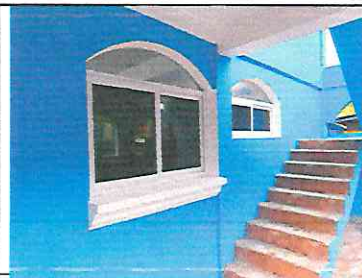
Foto 1: APLICACION DE PINTURA
