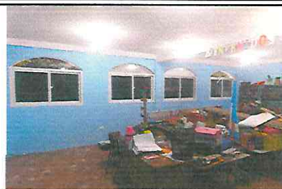
Foto 2: SUSTITUCION DE VENTANAS
