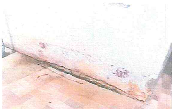
Foto 13: Repello, cernido y pintura en paredes en modulo de aulas
