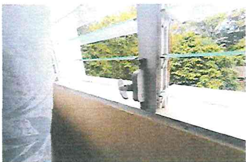
Foto 11: Sustitución de ventanas de vidrio (Persianas) por ventanas de PVC corredizas sin mosquitero, con vidrio de 5mm de grosor
