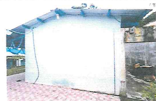
Foto 5: Pintura en muros interiores y exteriores (Incluye cepillado, lijado, limpieza y aplicación de pintura)
