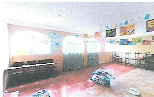
Foto 8: Sustitución de ventanas de vidrio (Persianas) por ventanas de PVC corredizas sin mosquitero, con vidrio de 5mm de grosor
