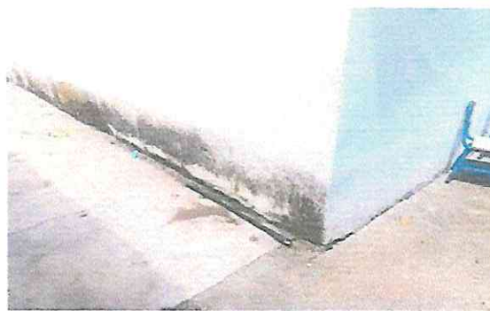
Foto 14: Repello, cernido y pintura en paredes en modulo de aulas
