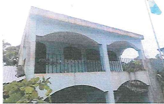
Foto 2: Pintura en muros interiores y exteriores (Incluye cepillado, lijado, limpieza y aplicación de pintura)
