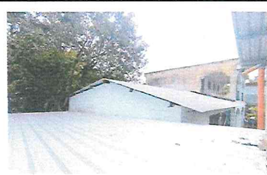
Foto 4: Pintura en muros interiores y exteriores (Incluye cepillado, lijado, limpieza y aplicación de pintura)
