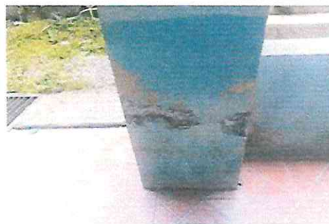
Foto 18: Repello, cernido y pintura en paredes en modulo de aulas
