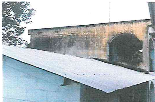
Foto 1: Pintura en muros interiores y exteriores (Incluye cepillado, lijado, limpieza y aplicación de pintura)
