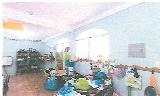
Foto 10: Sustitución de ventanas de vidrio (Persianas) por ventanas de PVC corredizas sin mosquitero, con vidrio de 5mm de grosor
