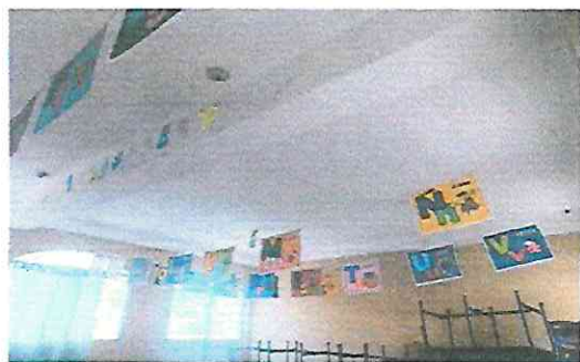
Foto 29: Suministro e instalación de plafoneras
