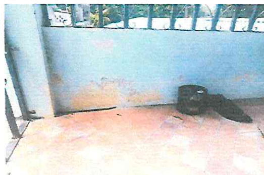
Foto 16: Repello, cernido y pintura en paredes en modulo de aulas
