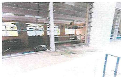
Foto 12: Sustitución de ventanas de vidrio (Persianas) por ventanas de PVC corredizas sin mosquitero, con vidrio de 5mm de grosor
