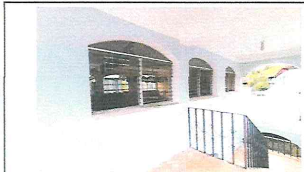
Foto 7: Sustitución de ventanas de vidrio (Persianas) por ventanas de PVC corredizas sin mosquitero, con vidrio de 5mm de grosor
