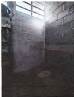
Foto 3: Área destinada a instalación de estufa rural.
