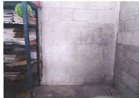
Foto 4: Área destinada a instalación de pila de block y cemento.
