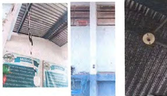
Foto 10: Suministro e instalación de sistema eléctrico.
