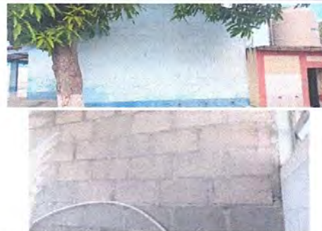
Foto 6: Repellos, cernidos y pintura en muros.
