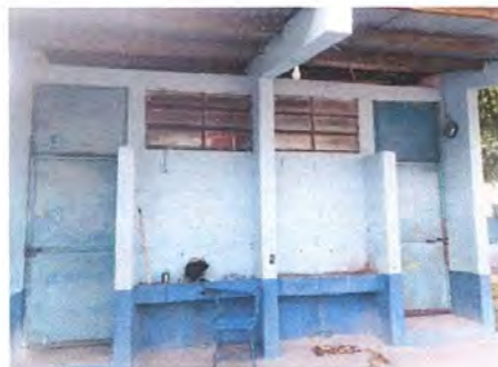
Foto 8: Sustitución de puertas de metal.
