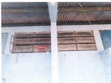
Foto 9: Sustitución de balcones de metal.
