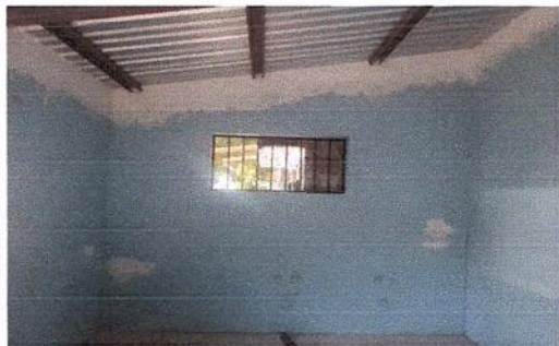
Foto 1: Fabricación de pila de concreto dentro de cocina.
