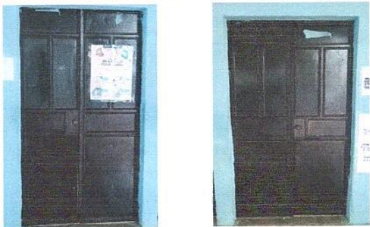
Foto1: Sustitución de puertas en 2 aulas
