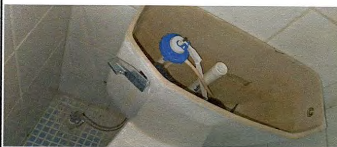
Foto 6: Las contrallaves de los sanitarios están en mal estado y es necesario el reemplazo para que puedan funcionar correctamente los sanitarios.
