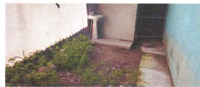
Foto 6: Suministro e instalación de pila de block, lámina troquelada y estructura de soporte de metal.
