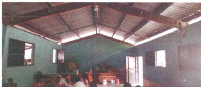
Foto 5: Suministro e instalación de revisión de metal de dos hojas abatibles en aulas
