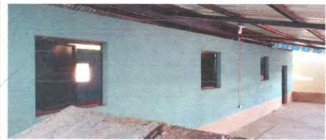
Foto 4: Instalación de balcones en aulas.
