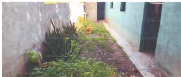
Foto 7: Suministro e instalación de planchas de concreto en patio.
