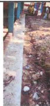
Foto 8: Suministro e instalación de cuneta de concreto para recolección de aguas pluviales en patio.
