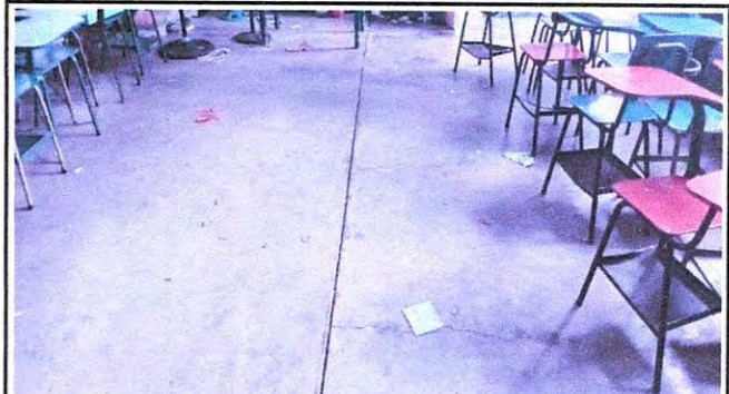
Foto 2: Retiro de Planchas en Mal Estado, Fundición de Piso de Concreto e Intalación de Piso Cerámico Mate en Aulas
