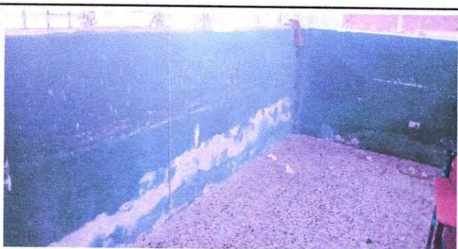
Foto 5: Repellos, Cernidos e Impermeabilización de Muros en Aulas
