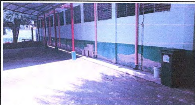
Foto 7: Repellos, Cernidos e Impermeabilización de Muros en Aulas
