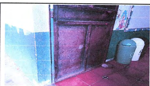
Foto 10: Mantenimiento de Puertas en Aulas
