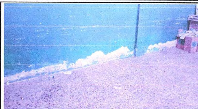
Foto 8: Repellos, Cernidos e Impermeabilización de Muros en Aulas
