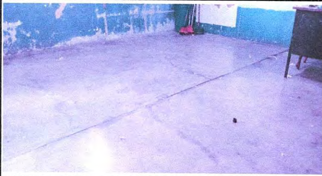
Foto 1: Retiro de Planchas en Mal estado, Fundición de Piso de Concreto e Intalación de Piso Cerámico Mate en Aulas
