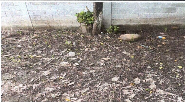
foto 17: fabricación de caja recolectora de agua pluvial de 1 x 1 x 1, ya que el agua no tiene salida y se emposa en el campo. Se conectará a los tubos de salida de agua que están tapados.
