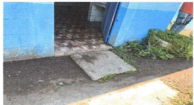
foto 16: fundición de banqueta, para evitar que el agua se empose y se haga lodo.
