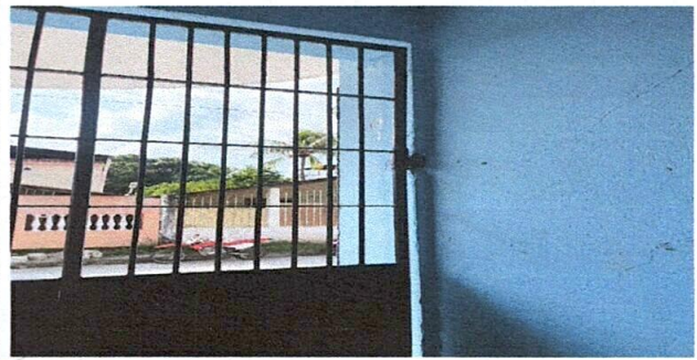
foto 20: reparación de portón, hay que levantarlo porque se bajó y cuesta cerrarlo.
