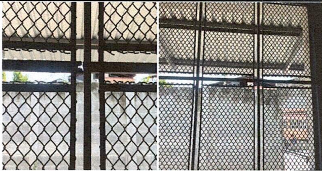
foto 21: mantenimiento a balcones, reparación, lijado y pintura.
