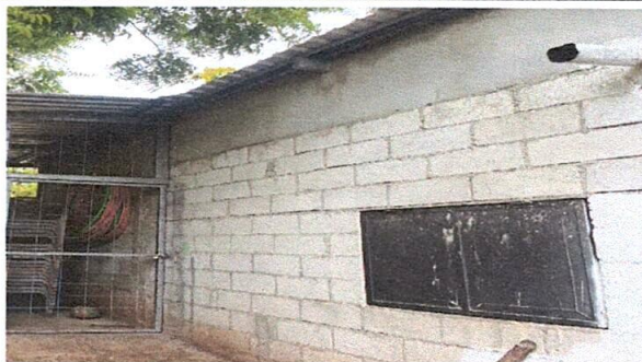
Foto 4: suministro instalación de lámina y estructura metálica para pila, se va a empotrar al muro de la cocina.
