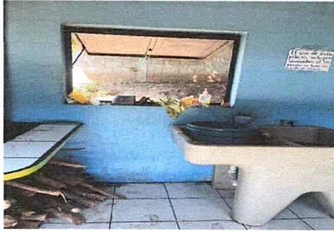
foto 7: apertura de vano para puerta e instalación de puerta metálica, para tener acceso a la pila.
