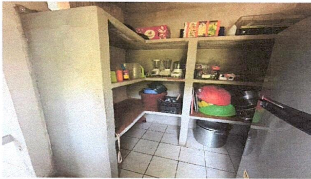
foto 9: instalación de azulejo en muebles de cocina
