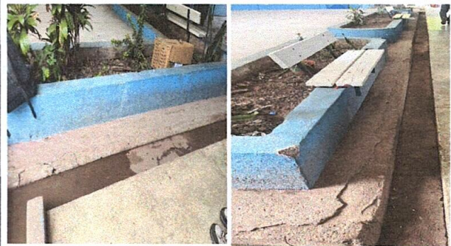
foto 14: sustitución de línea principal de drenaje
