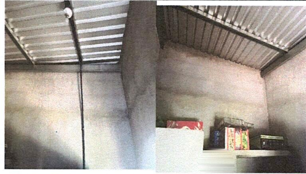
foto 10: mantenimiento de paredes, aplicación de cerniao y pintura.
