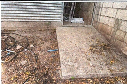
Foto 1: Sustitución de rampa por losa de patio de concreto, para colocar pila
