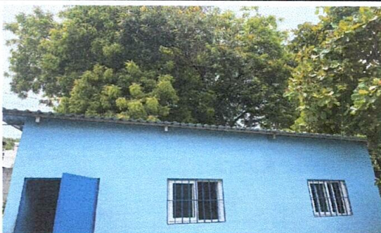
foto 11: instalación de canal de metal y bajante de agua pluvial de tubo de 4"
