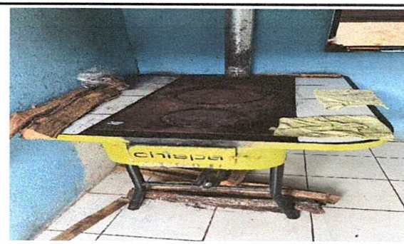
Foto 6: Sustitución de estufa rural (completa) incluye chimenea y 2 planchas de metal de 2 hornillas, dimensiones de 1.5x0.7x1m
