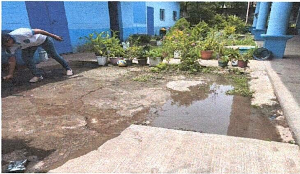
foto 15: fabricación de cajas recolectoras de agua pluvial y sustitución de losa.
