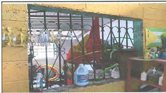
Foto 8: Sustitución de Ventana de Vidrio por ventana de pvc corrediza
