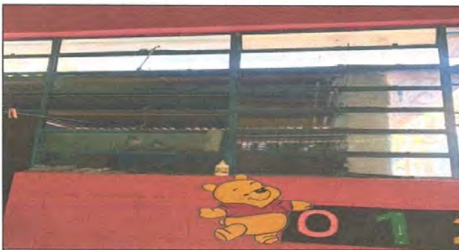
Foto 5 Sustrucción de ventana de vidrio por ventana corrediza PVC
