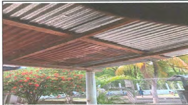
Foto 10: Sustitución de estructura de techo de madera por estructura metálica.
