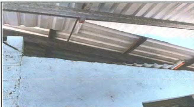
Foto 7: Reparación y Cernido de Pared
