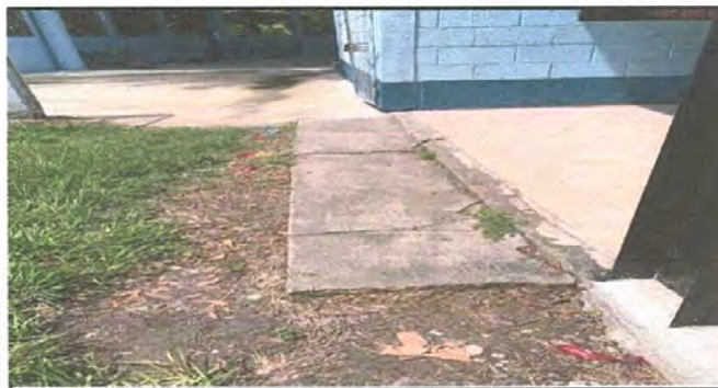
Foto 11: demolición de piso existente y nivelación de piso
