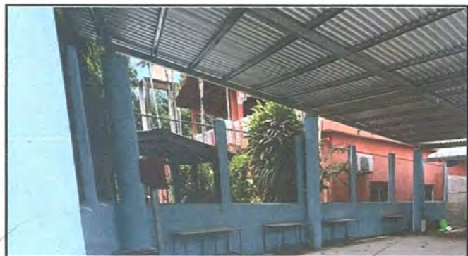
Foto 4 Mantenimiento a barandas de metal
