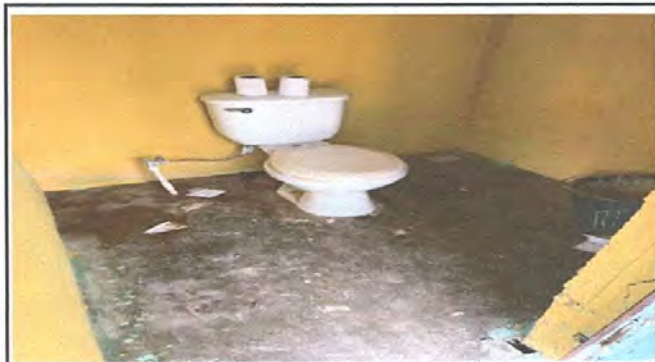
Foto 9: Sustitución de inodoro, sus accesorios y piso cerámico.
