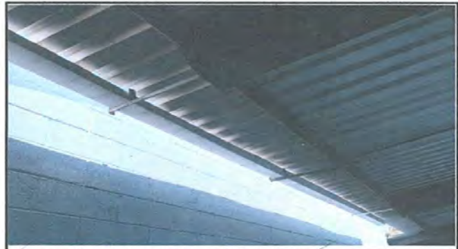
Foto 2 Sustrucción de canal de metal
