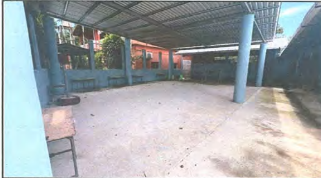
Foto 1 Sustrucción de torta de cemento por piso cerámico antidelisante
