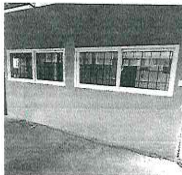
Foto 2: Suministro e instalación de ventanas corredizas de PVC vidrio oscuro de 5mm. De grosor
