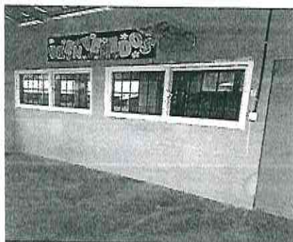
Foto 3: Suministro e instalación de ventanas corredizas de PVC vidrio oscuro de 5mm. De grosor
