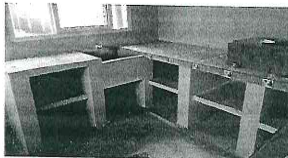
Foto 11: Sustitución de estufa rural completa (Incluye polletón. Plancha metálica y chimenea)
