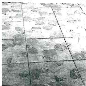
Foto 12: Suministro de piso cerámico en modulo de cocina
