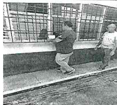
Foto 4: Suministro e instalación de ventanas corredizas de PVC vidrio oscuro de 5mm. De grosor
