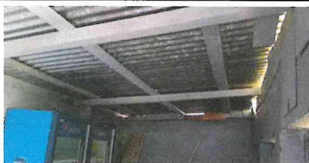
Foto 1: Sustitución de lamina y estructura de metal en cocina
