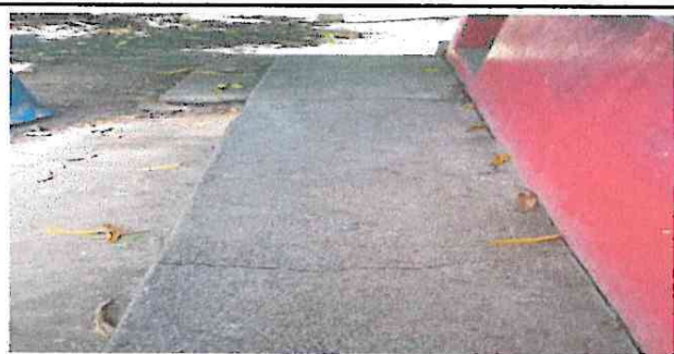
Foto 5: Sustitución de banqueta, introducción de agua potable en cocina
