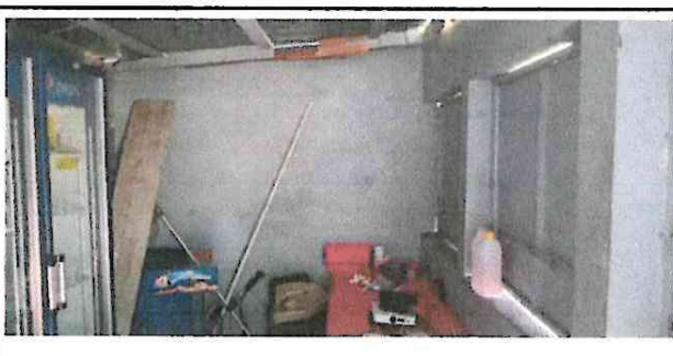
Foto 6: Instalación de mueble de concreto y pila en cocina
