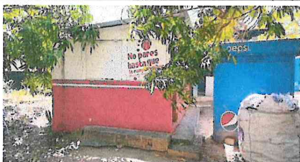
Foto 3: Levantado de muros corridos y pintura en cocina
