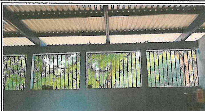
Foto 2: Entabicado en Muros en Aulas
