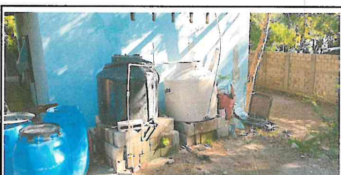
Foto 6: Sustitución de Sistema de Agua e Instalación de Tubería de Agua Potable en Baños
