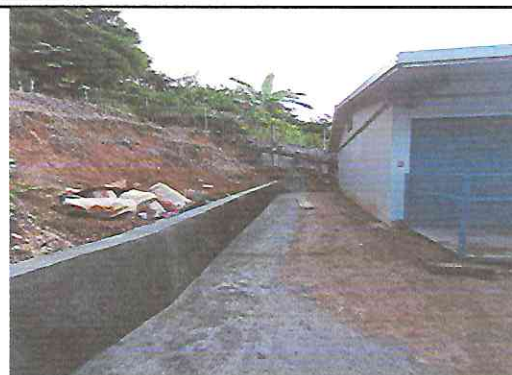
Foto 4: REPARACION Y ANIVELACION DEL MURO DE CONTENCIÓN
