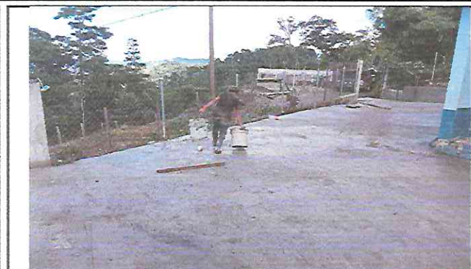
Foto1: SUSTITUCION DE TORTA DE CONCRETO MAS ANIVELACION
