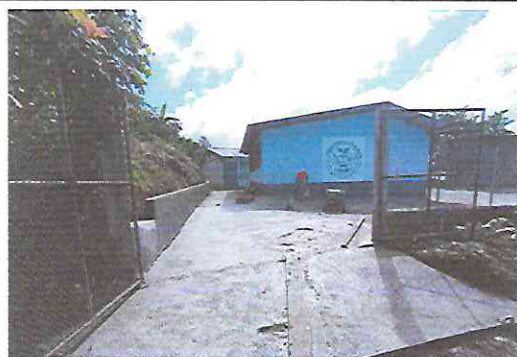
Foto 5: SUSTITUCION DE TORTA DE CONCRETO POR RAMPA
