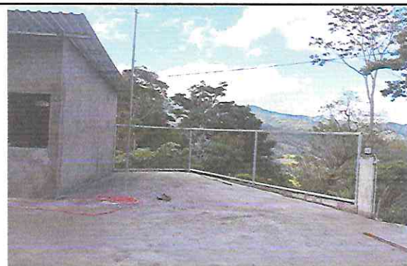
Foto 3: SUSTITUCION DE TUBO Y MALLA
