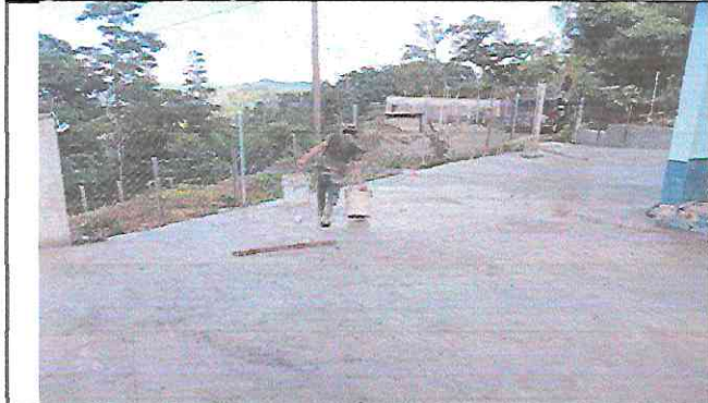
Foto1: SUSTITUCION DE TORTA DE CONCRETO MAS ANIVELACION
