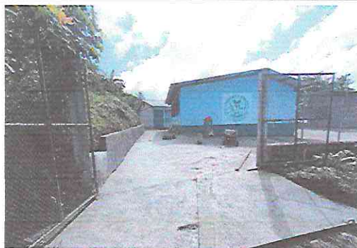
Foto 5: SUSTITUCION DE TORTA DE CONCRETO POR RAMPA
