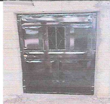
Foto 7: SUSTITUCION E INSTALACION DE PUERTA
