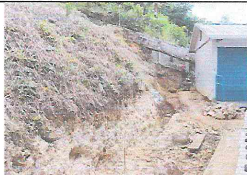
Foto 4: REPARACION Y ANIVELACION DEL MURO DE CONTENCIÓN
