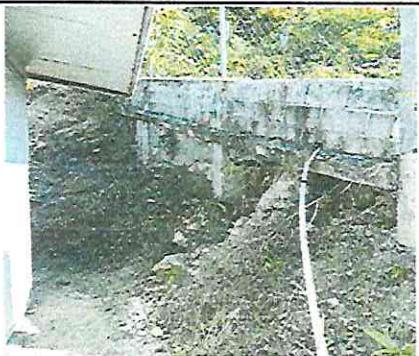
Foto 7: reparación del muro perimetral (excavación, anivelación y relleno compactado)
