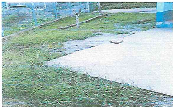
Foto 1: Sustrucion de torta de concreto mas anivelacion
