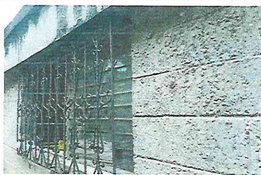
Foto 9: sustitución e instalación de ventana
