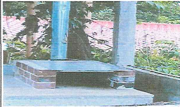
Foto 2: reparacion de estufa
