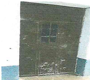
Foto 8: sustitución e instalación de puerta
