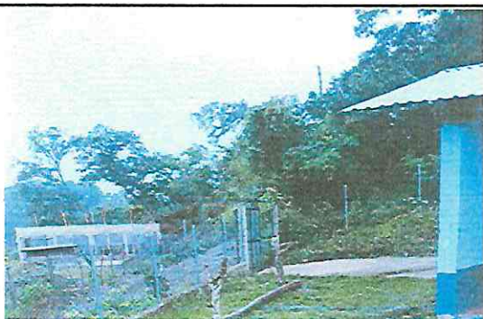
Foto 5: sustitucion de torta de concreto por rampa
