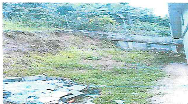
Foto 4: reparacion y anivelacion del muro de contencion
