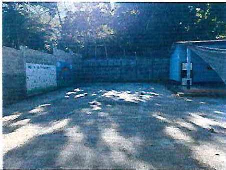
Foto 9: Area recreativa con piso nuevo de concreto.
