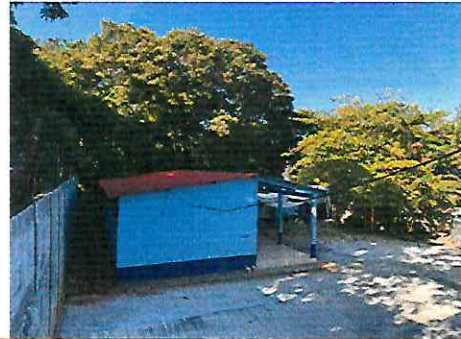
Foto 8: Techo de aulas luego de la limpieza y aplicación de anticorrosivo.
