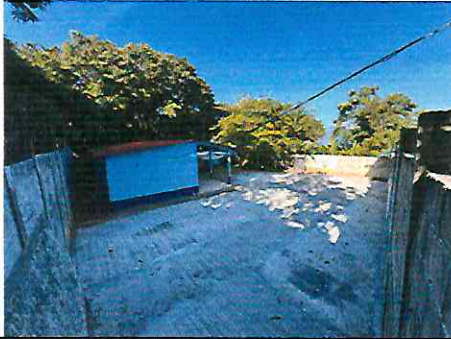
Foto 7: Area recreativa con piso nuevo de concreto.
