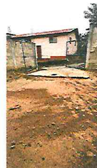
Foto 2: Etapa de preparación de base para fundición de torta de concreto.
