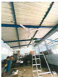
Foto 5: Proceso de cableado e instalacion de ventiladores.
