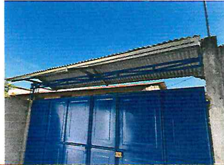
Foto 2: Techo sobre porton e ingreso peatonal.
