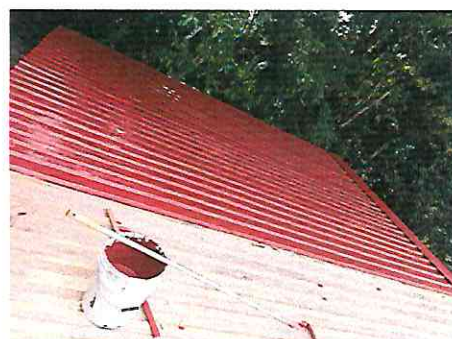
Foto 4: Limpieza, lijado e inicio de trabajos de aplicación de pintura anti corrosiva en cubierta de lamina.
