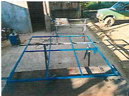
Foto1: Etapa de fabricación del porton de acceso principal
