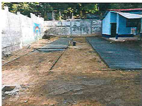
Foto 3: Inicio de la etapa de fundición de torta de concreto + electromalla
