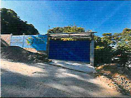
Foto1: Porton nuevo, instalado.
