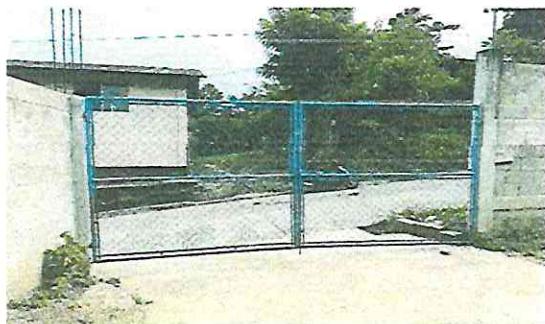
Foto 1: En la fotografía observamos el porton actual el cual se pretende sustituir e instalar un techo para proteccion del mismo
