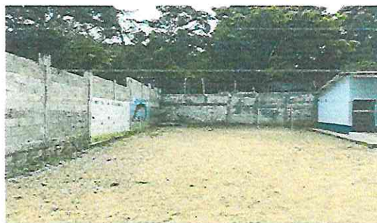
Foto 2: Area de sustitucion de piso de tierra con piso de concreto, esto para mejorar las condiciones de recreacion de los alumnos y evitar el encharcamiento en temporada de invierno.
