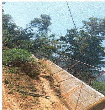
Foto 2: repello en muro
