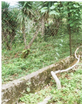
Foto1:Sustrucción tubo HG malla galvanizada
