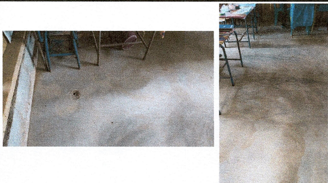
Foto1:Sustitución de piso de cemento por piso ceramico
