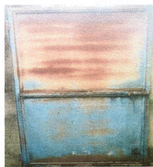
Foto 6: Sustrucción de puerta de petal de metal en servicios sanitario 0.90mt de alto por 2.15mt de ancho
