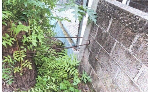
REPARACIÓN DE VIGA+ COLUMNA DE SOPORTE
