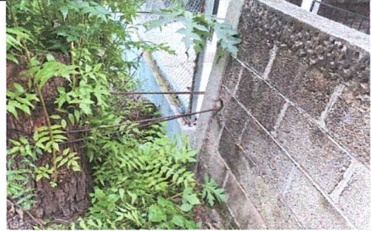
REPARACIÓN DE VIGA+ COLUMNA DE SOPORTE
