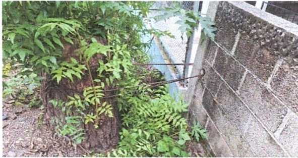
SUSTITUCIÓN DE TRAMOS DAÑADOS CON MAMPOSTERÍA DE BLOCK
