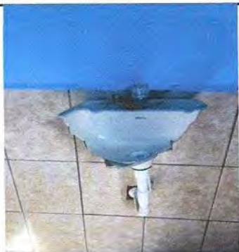
SUSTITUCIÓN DE MEZCLADORA LAVAMANOS (CONTRA LLAVE, TUBO DE ABASTO)
