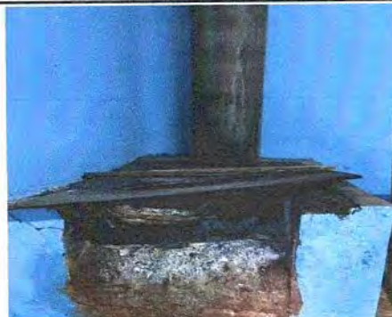
MANTENIMIENTO A ESTUFA RURAL
