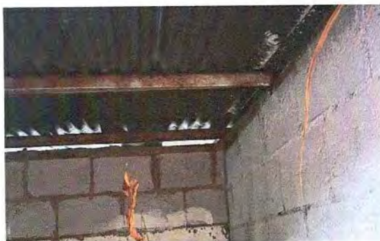
MANTENIMIENTO A ESTRUCTURA DE SOPORTE DE METAL CON PINTURA ANTICORROSIVA
