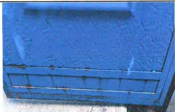
MANTENIMIENTO A PUERTAS DE SANITARIOS
