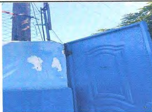
REPARACIÓN DE SOLERA CORONA
