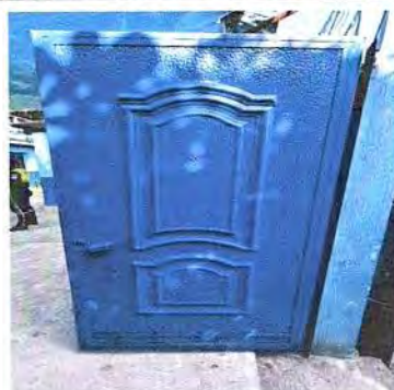
MANTENIMIENTO DE PORTON DE METAL
