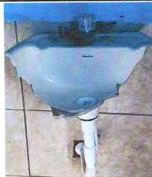
SUSTITUCIÓN DE LAVAMANOS
