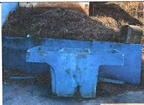
SUSTITUCIÓN DE PILA DE CEMENTO DE 2 LAVADEROS + TOP DE PILA CON AZULEJO
