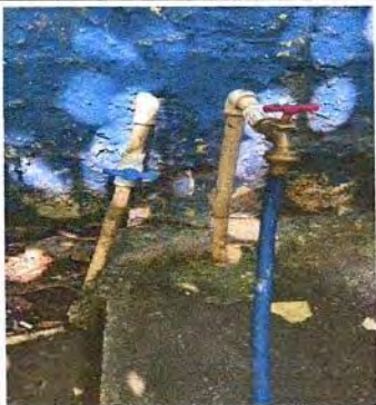
INSTALACIÓN DE CAJA + VÁLVULA DE SISTEMA DE AGUA POTABLE
