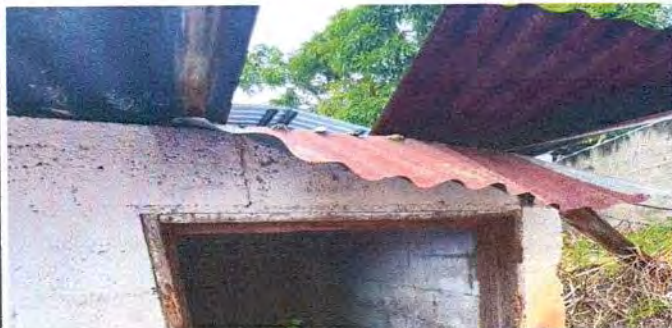
SUSTITUCIÓN DE LÁMINA POR LÁMINA TROQUELADA CALIBRE 26
