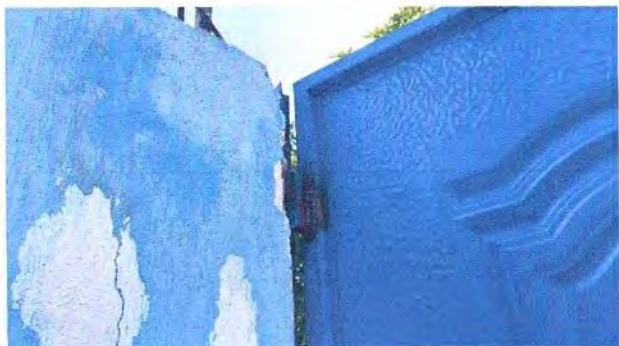
REPARACIÓN DE VIGA TIPO DIENTEL + COLUMNA DE SOPORTE
