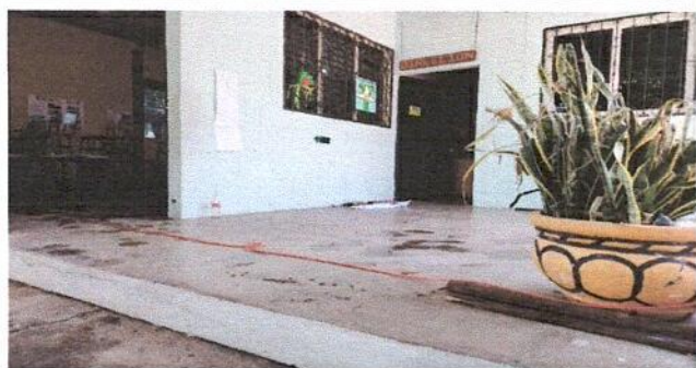
Antes: Instalación de piso cerámico
