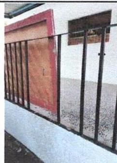
Antes: Sustitución de barandas de metal
