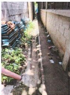
Antes: Reparación de cuneta de concreto
