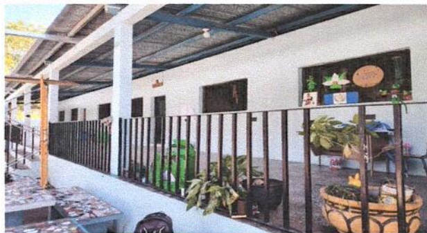
Antes: Pintura de muros exteriores
