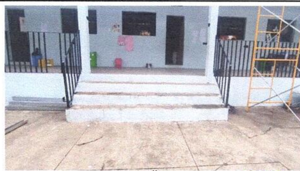
Antes: Reparación de gradas
