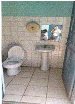
Sustitución de sanitario, piso, azulejo y lavamanos.
