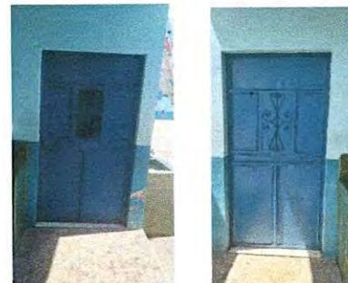
Sustitución de puertas de metal
