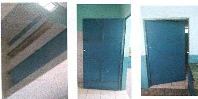
Mantenimiento de puertas, lijar y pintar
