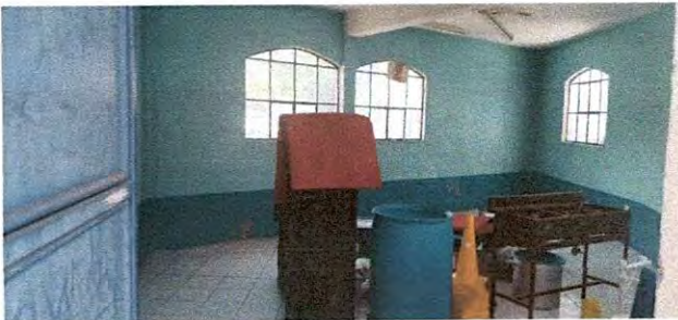
Pintura interior del Aula
