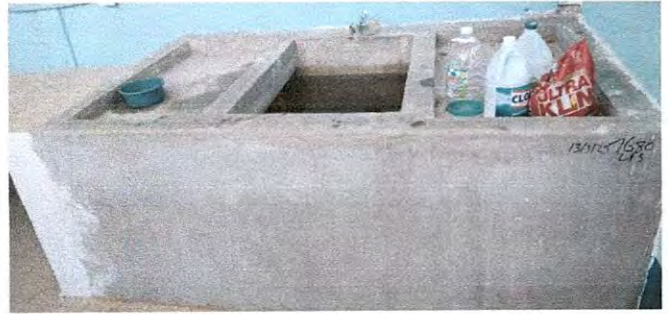
Instalación de de azulejo en pila
