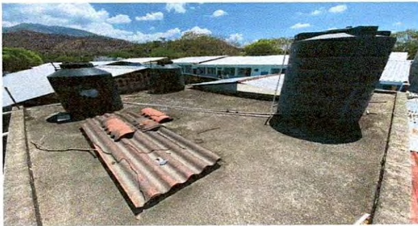
Limpieza, Nivelación, impermeabilización de terraza
