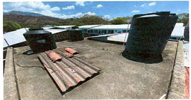
Sustitución de Cisterna de agua y de red de agua potable
